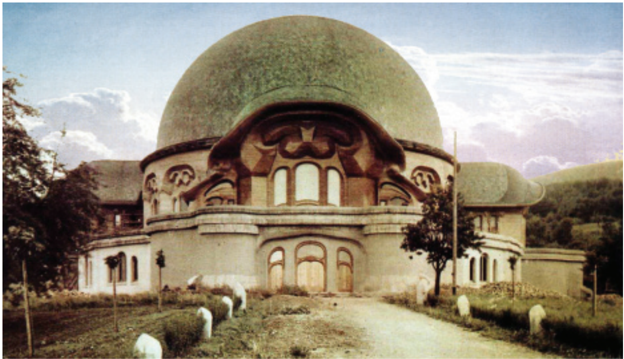
Первый Гётеанум. Главный вход
